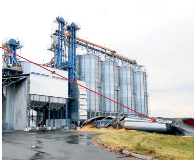
Рис. 13. Силоси С5К210 після падіння
