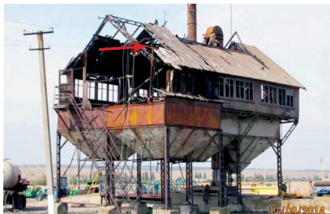
Рис. 9. Загальний вигляд ЗАВ-40 після пожежі й місце електричного вводу (показано стрілкою)
