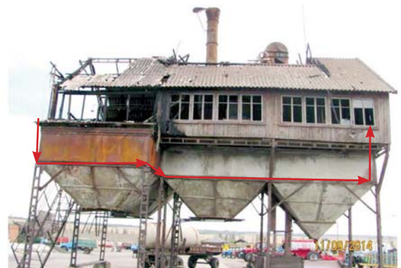
Рис. 11. Довжина ділянки кабельної лінії по корпусу ЗАВ-40
