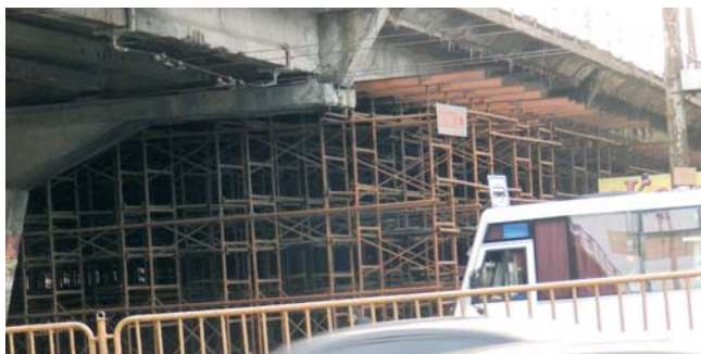
Рис. 22. Загальний вигляд Шулявського шляхопроводу
