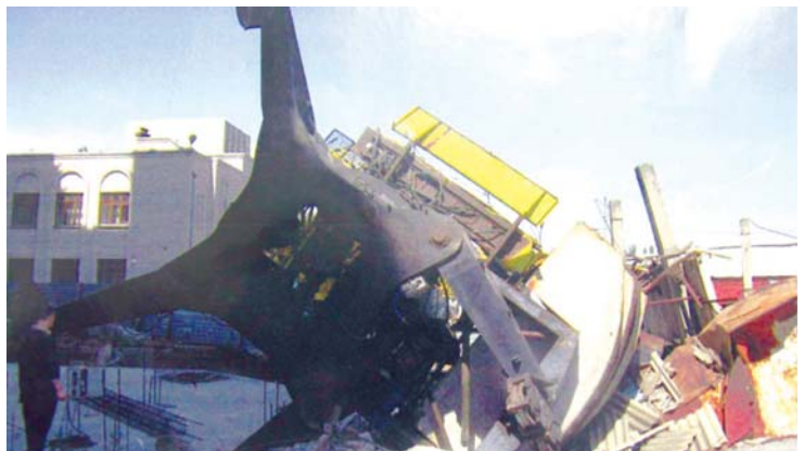
Падіння баштового крана КБ-405 (м. Харків)
