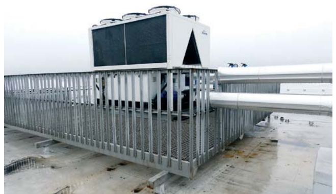
Рис. 19. Відсутність блискавкоприймальних штирів навколо чилера висотою 2,7 м
