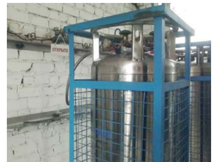
Кріостат має зовнішнє огороження, а також запобіжний клапан і розривну мембрану
