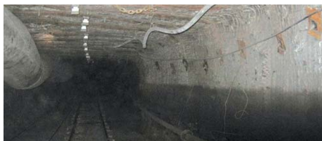
Рис. 2. Застосування технології анкерного кріплення
